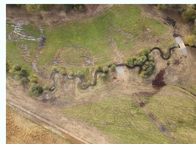
Exemple de reméandrage en fond de vallée
