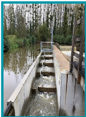
La passe à bassins du Moulin du Bas Coudray au Genest Saint Isle
