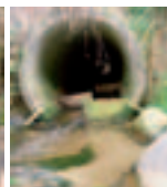
Après aménagement du franchissement
