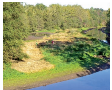
Chantier 2010 sur La Colmont
