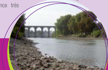
Barrage de Bootz
